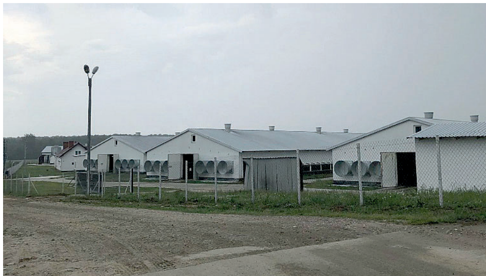
Fotografia 1. Ferma drobiu we Wróblewie licząca 10 hal hodowlanych
