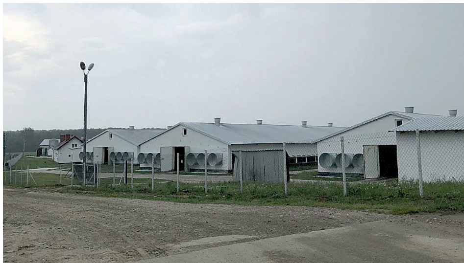
Fotografia 1. Ferma drobiu we Wróblewie licząca 10 hal hodowlanych
